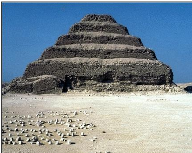
Slika 4: Stepeničasta piramida u Sakkari. Imhotep, savjetnik kralja Djosera iz III dinastije, projektirao je i izgradio prvu piramidu u Sakkari, koja još pokazuje utjecaj zigurata s područja Mezopotamije, ali za razliku od zigurata, koji su građeni od cigle, piramide su građene kamenom.
